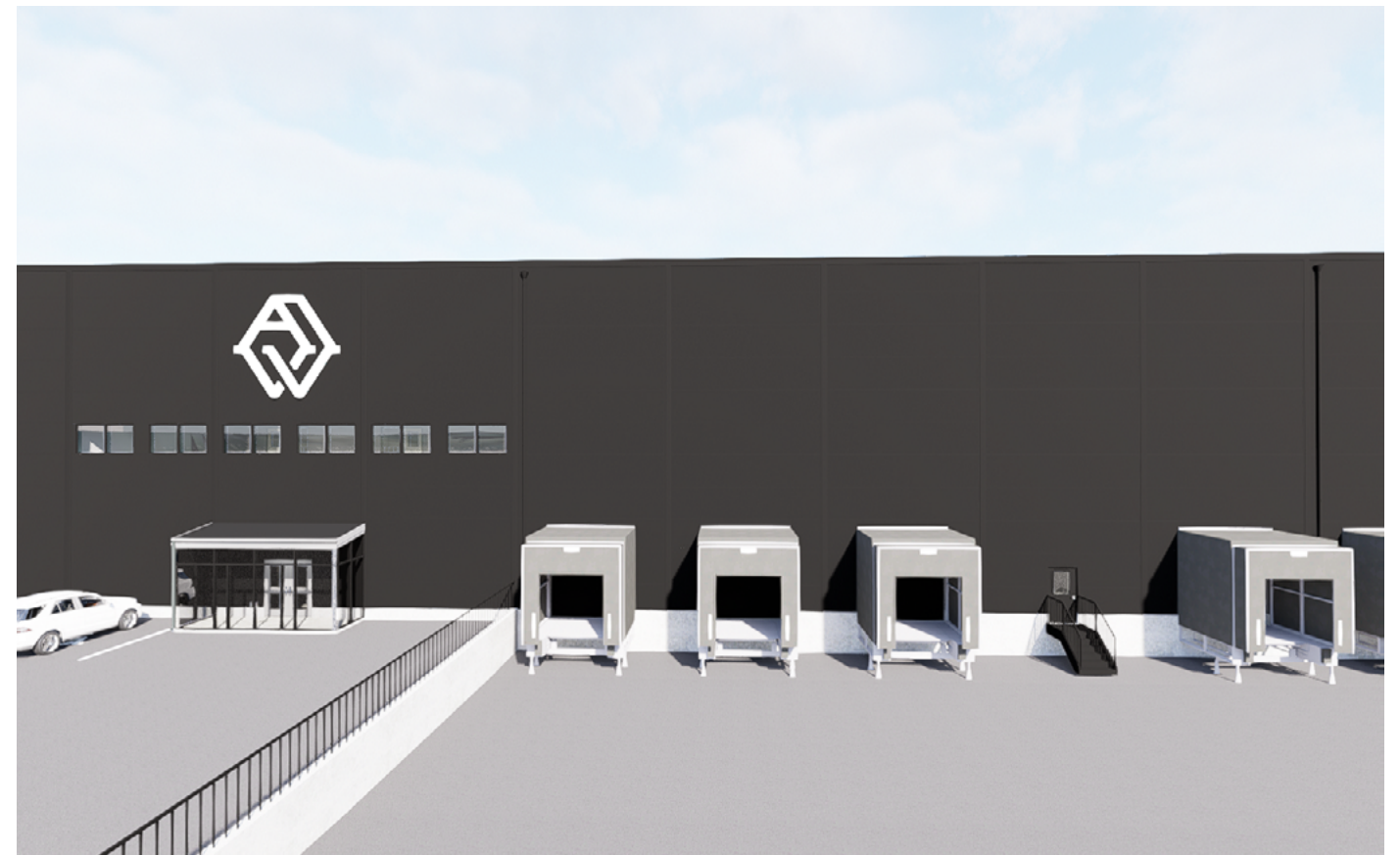
Exempel på fasad med lastbryggor.
